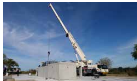
Pose des modules béton constituant la plateforme
