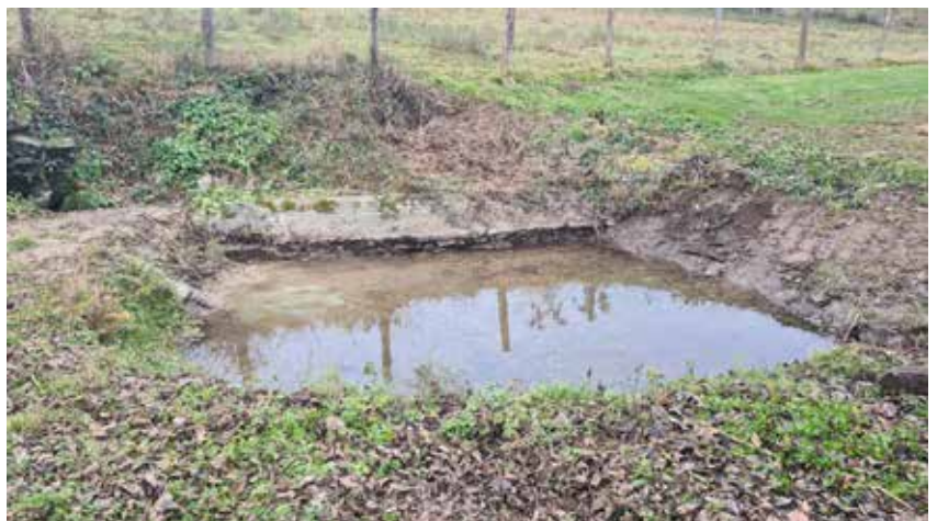
Travaux de restauration
